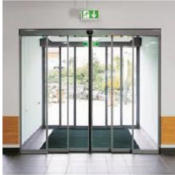
מערכת טלסקופית דו צדדית כפולה (Air Lock)
