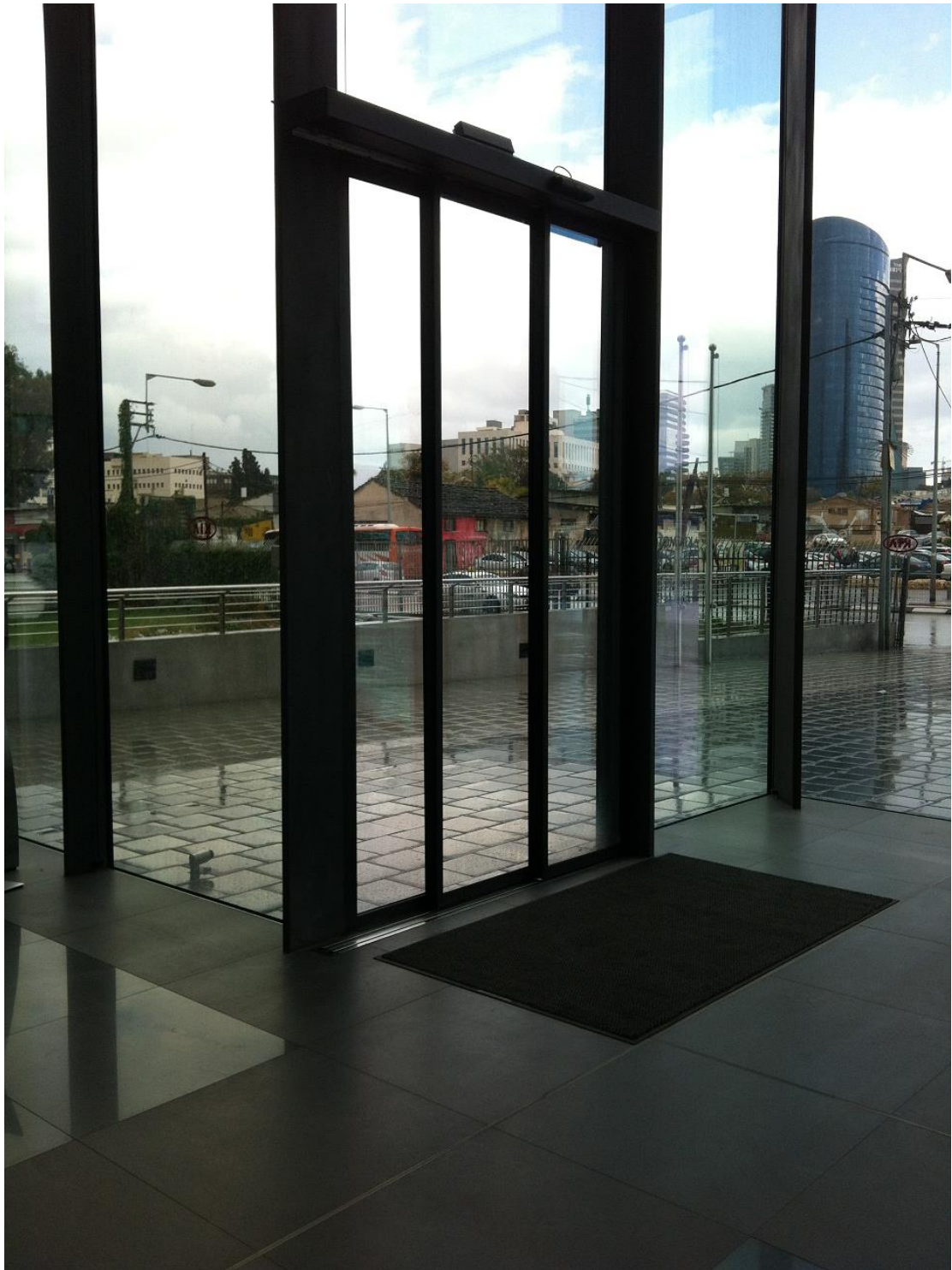
מערכת הזזה אוטומטית טלסקופית DORMA ES 200 TST נפתחת ימינה, כניסה דרומית, מבט מבפנים.
