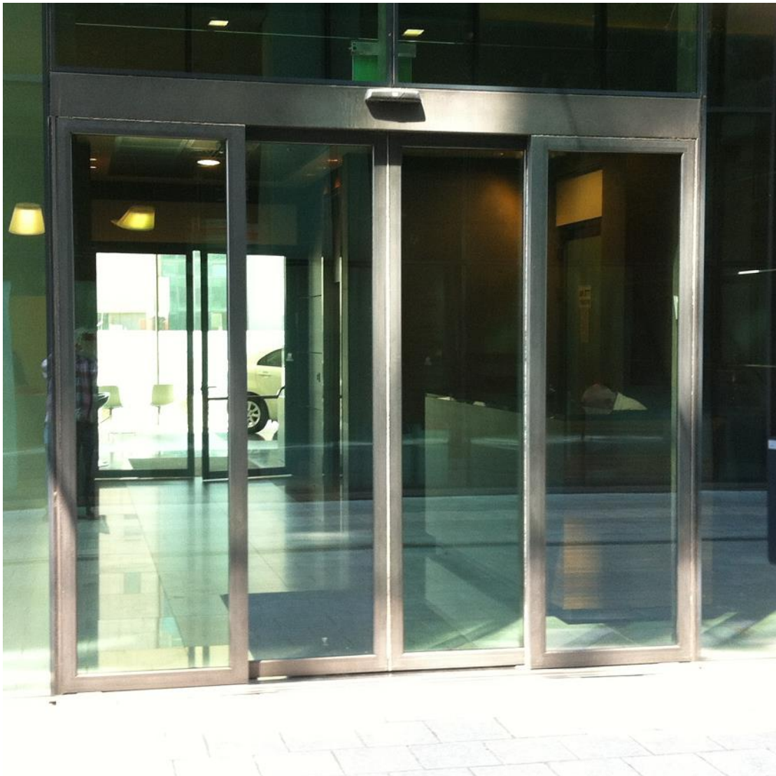
מערכת דלת הזזה אוטומטיות קורסות DORMA ES 200 EASY – SST/BR
