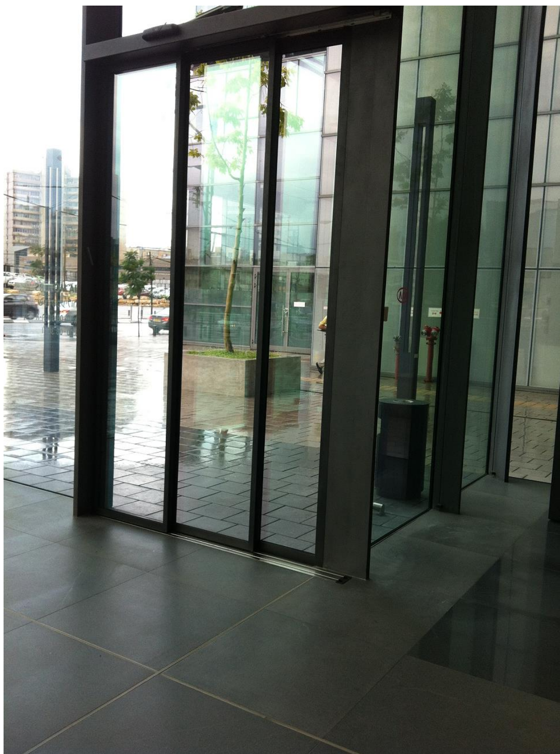
מערכת הזזה אוטומטית טלסקופית DORMA ES 200 TST נפתחת שמאלה, כניסה צפונית, מבט מבפנים.
