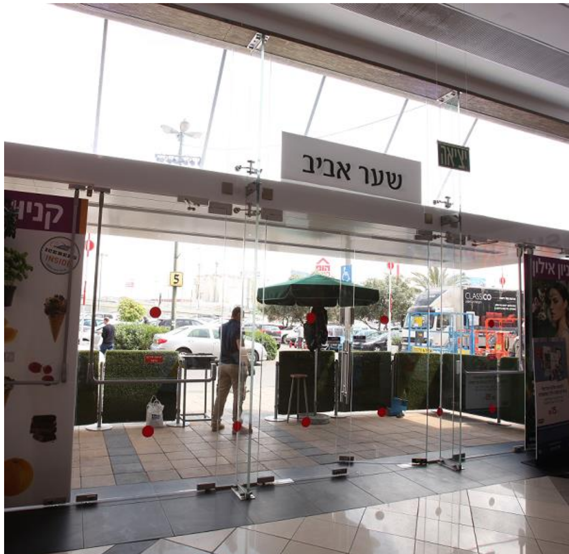
דלתות כניסה ראשיות עם מערכת אוטומטית לפתיחה בזמן אש בשילוב ידידות בהלה
